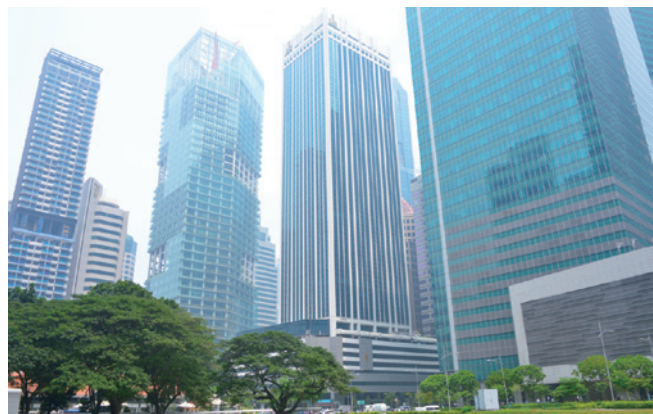
事例⑧ 40階に駐在員事務所があるHong Leong Building(写真中央)
